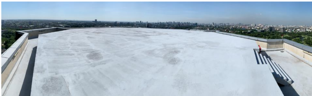
รูปถ่ายดาดฟ้า
