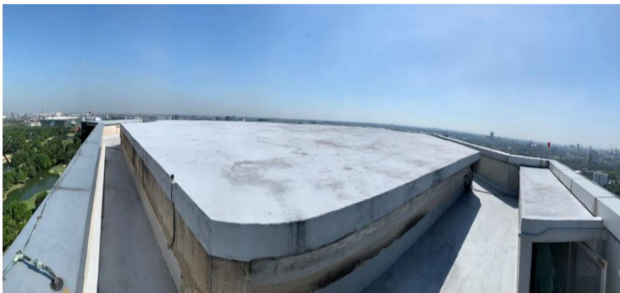
รูปถ่ายดาดฟ้า
