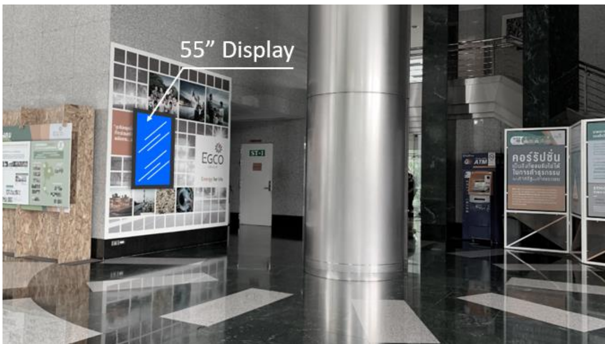
สถานที่ติดตั้ง Touch screen display (ชั้น 1)
