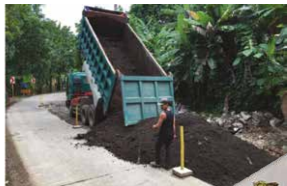
เถ้าหนักใช้ในการถมถนน ในโครงการถนนคอนกรีต ของกรมโยธาธิการ และทางหลวง
