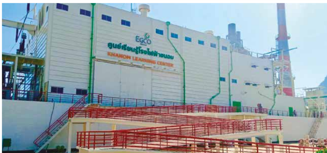
โรงไฟฟ้าขนอม หน่วยที่ 1
